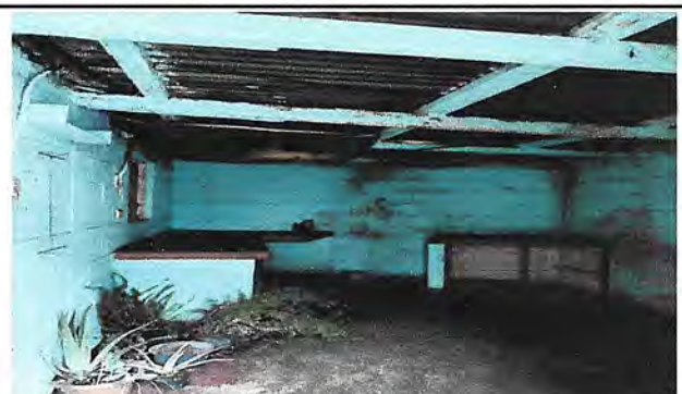
Foto 4: área de sustitución de costaneras y láminas.
