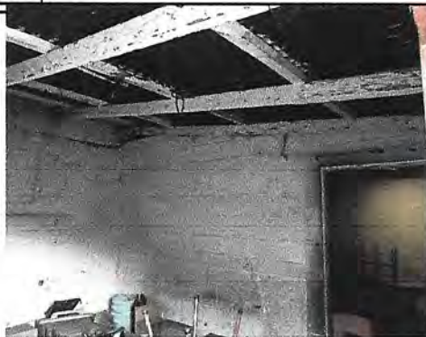
Foto 7: área de aulas para el cambio de techo y costaneras.
