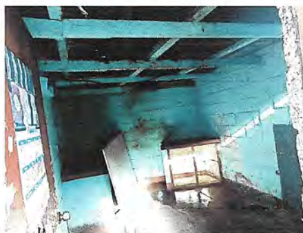
Foto 5: área para el cambio de costaneras.
