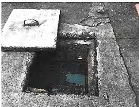
Foto 1: extracción y limpieza de fosa séptica.
