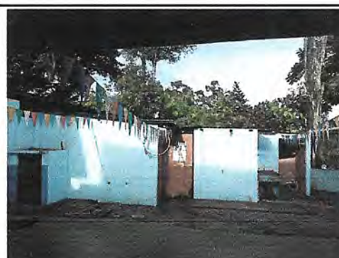
Foto 4: aulas para el cambio de costaneras y enlaminado.
