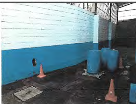
Foto 3: rompimiento de pared para la limpieza de la fosa séptica.
