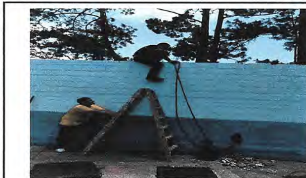
Foto 3: rompimiento de pared para el mantenimiento de la fosa.
