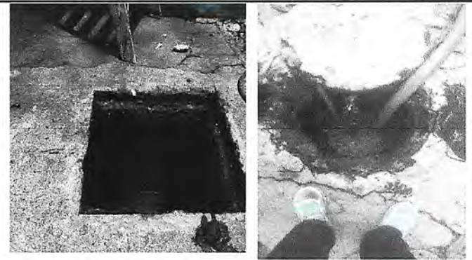
Foto 2: abertura de la fosa dentro del establecimiento.
