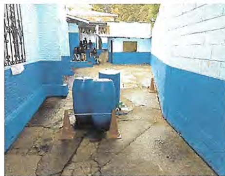
Foto 2: espacio del corredor donde se encuentra la fosa séptica.
