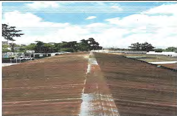
Foto 1: Cubierta de lámina de 4 aulas y 2 bodegas, pasillos 332m2.
