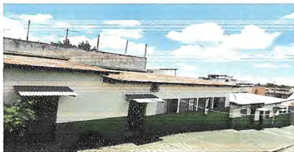
Foto 3: Piso: Cubierta de lámina de dos aulas 121 metros cuadrados.
