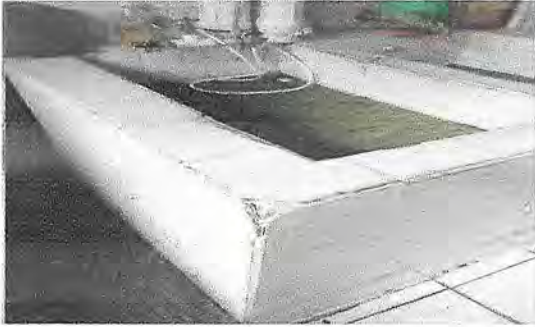
Foto1: AZULEJO ( Sustrución de azulejo de pila de cocina 7mts. cuadrados)
