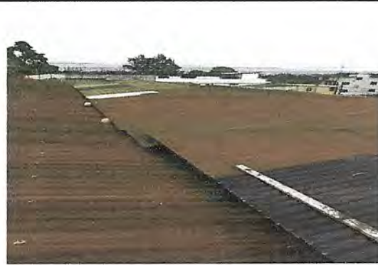
Foto 2: Cubierta de lámina de escenario 104mts. cuadrados.
