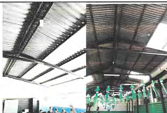
Foto 4: Estructura de techo: Mantenimiento de pintura de la estructura de 6 aulas, 2 bodegas, pasillo y escenario.
