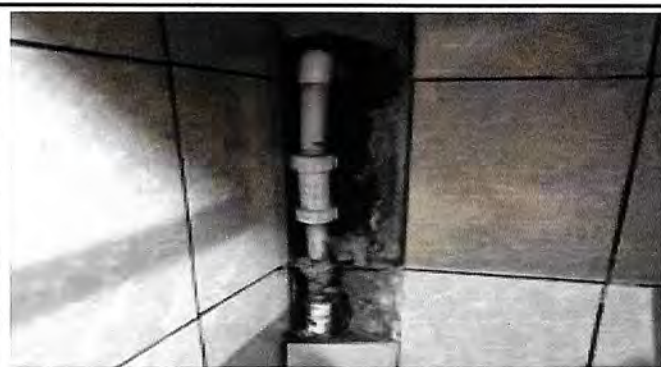
Foto 3: Reparación de tubería relleno e instalación de azulejo (si lo requiere).
