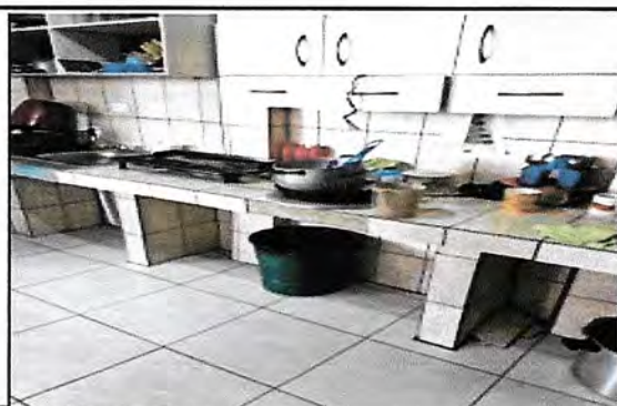
Foto 5: Instalación de azulejo cementico.
