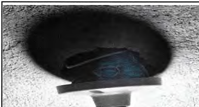
Foto 4: Reajuste de elemento eléctrico.
