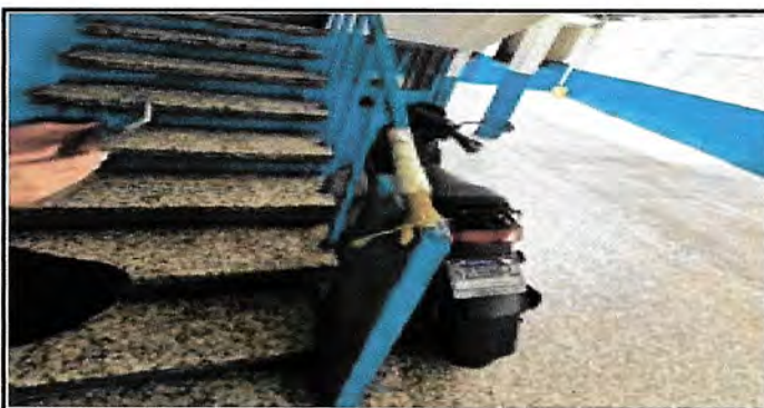
Foto 11: Instalación de baranda metálica.
