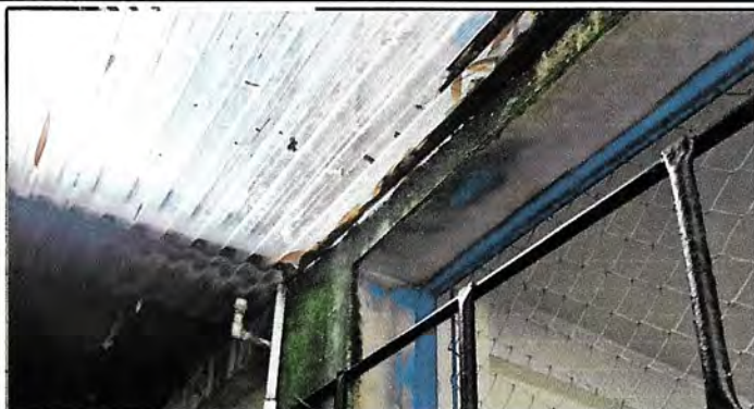
Foto 1: Cambio de lamina.
