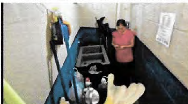
Foto 10: Instalación de pila.
