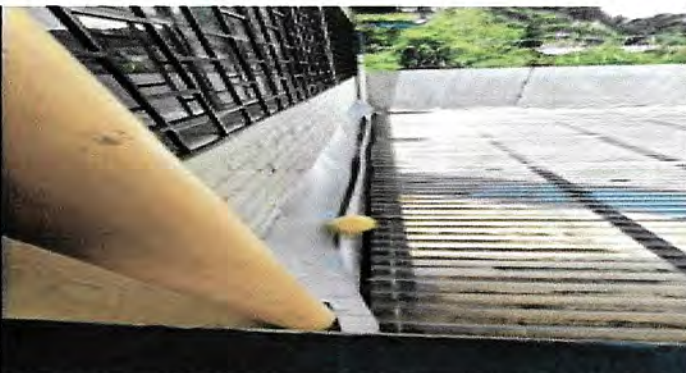
Foto 9: Reajuste e instalación de canaleta para retención de agua pluvial.
