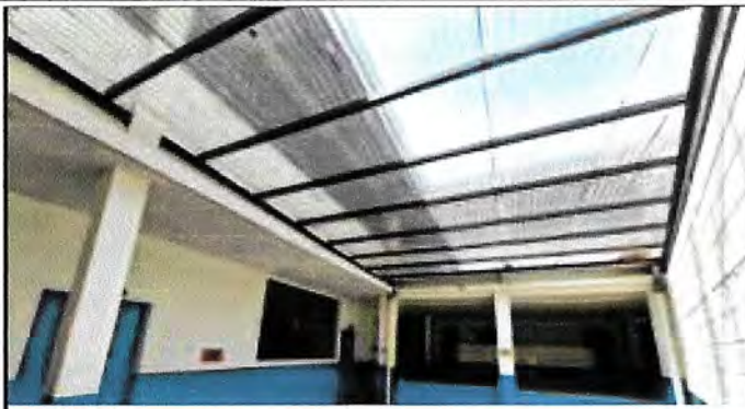
Foto 8: Desmontaje y montaje de lámina con resistencia térmica.
