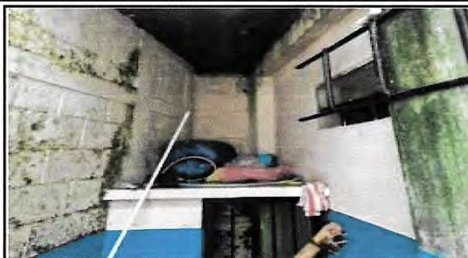
Foto 2: Limpieza de paredes para eliminación de moho, resane y pintura.
