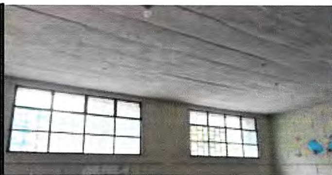
Foto 15: Colocar extractor de aire.
