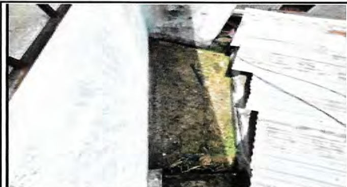
Foto 13: Impermeabilización de mortero cementico en losa expuesta.
