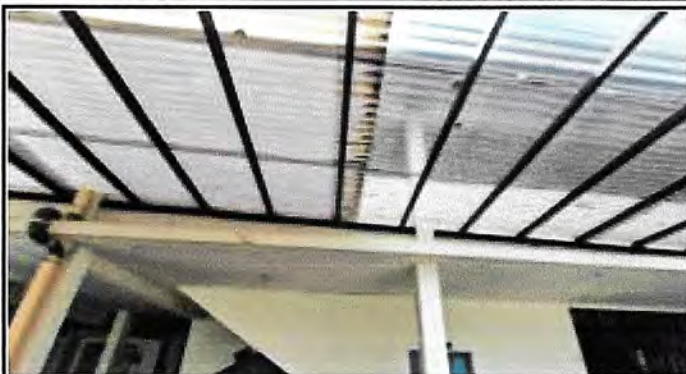
Foto 7: Instalación de juntas.
