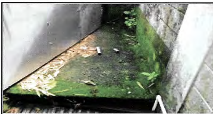
Foto 6: Limpieza de superficie con moho e impermeabilización con mortero
