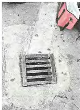
Foto1: Limpieza de rejilla de desagüe.
