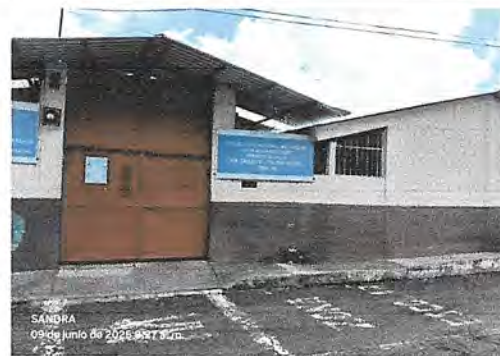
Foto 2: Se pintará el portón de la entrada del establecimiento.
