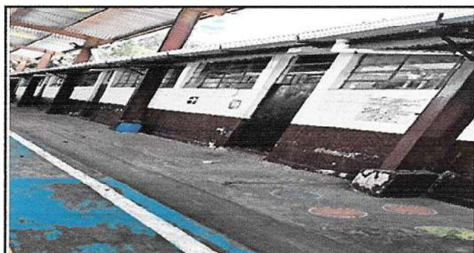
Foto 10. Pintura en socalo de 5 aulas 40ml
