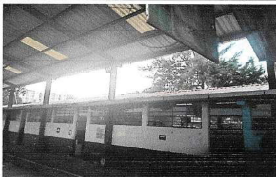
Foto 1: Sustrucción de laminas viejas 488ml de 5 aulas por lamina nuevas e instalación de 25 capotes.
