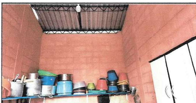
Foto 12 : Ampliación de cocina y habilitar puerta .
