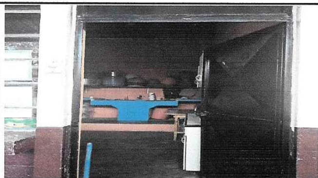
Foto 3: Reparación y ampliación de área de cocina
