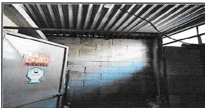
Foto. 11Traslado y habilitación de sanitario con accesorios.
