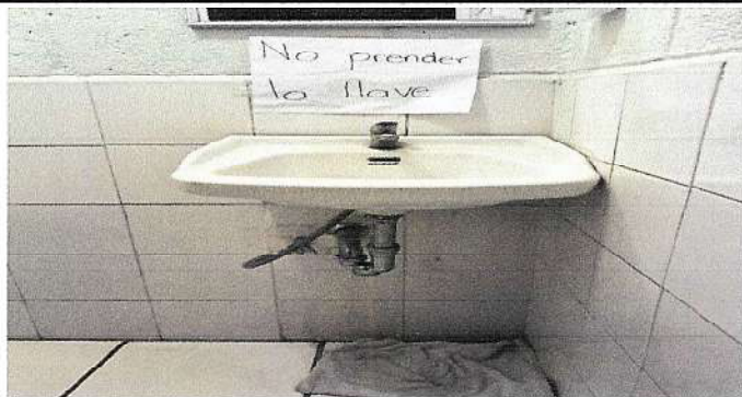
Foto 8 Sustitución de Cifon de lavamanos
