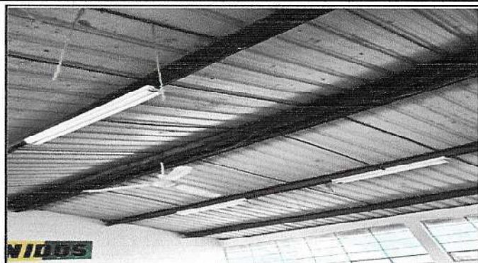
Foto7: Reparación y sustitución de 22 tubos tipo Neon por LED, colocación de 5 bombillas Led
