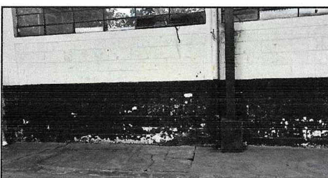
Foto 6: Pintura en socalo de 5 aulas 40ml
