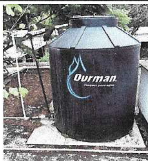
Foto 7: Instalación de accesorios del depósito de agua ya existente.
