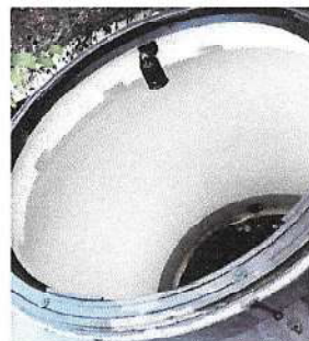
Foto 8: Instalación de accesorios del depósito de agua ya existente.
