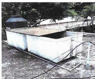
Foto 5: Sustitución de depósitos de agua
