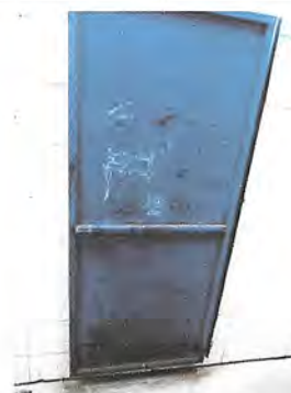
Foto 2: pintura de puertas
