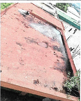
Foto 6: REPARACION DE BAJADAS PLUVIALES Y SUSTITUCION DE MEZCLON MAS IMPERMEABILIZACION.
