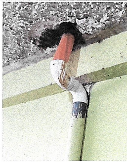
Foto 6: REPARACION DE BAJADAS PLUVIALES Y SUSTITUCION DE MEZCLON MAS IMPERMEABILIZACION.
