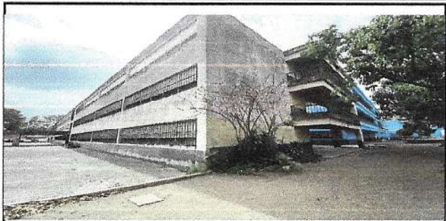
Parte lateral hacia el lado occidente, a realizar pintura en el cuarto módulo, con fondos provenientes del Programa de Apoyo "Mantenimiento de Edificios Escolares Públicos"
