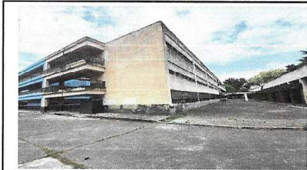
Trabajos de pintura a realizar, parte de atrás del 4to. Módulo, con fondos provenientes del programa de apoyo "Mantenimiento de Edificios Escolares Públicos"
