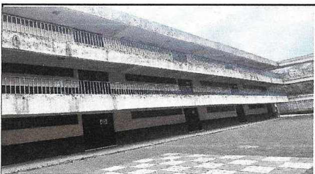
Parte Frontal del cuarto módulo, ala izquierda hacia el oriente, pintura de paredes, cornisa de concreto y columnas
