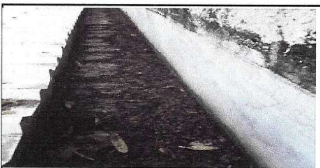
Foto 5: CANALETA DE CONCRETO, LIMPIAR Y REMOZAR
