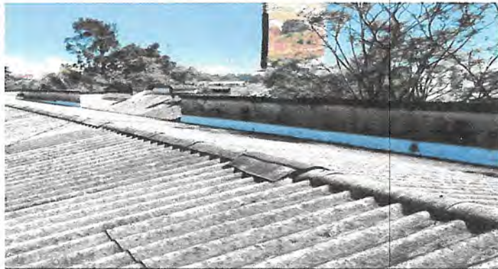
Foto 3: Sustitución de capota de duralita por capota de aluzinc calibre 26 de 45 mts lineal en áreas frontal segundo nivel de escuela.
