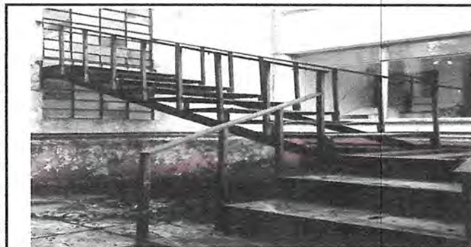
Foto 5: Limpieza y pintura se aplicaran 1600.00 m2 en los muros interiores según indicaciones del IDHAE y la Municipalidad Art Deco 15 y Art Deco 13.
