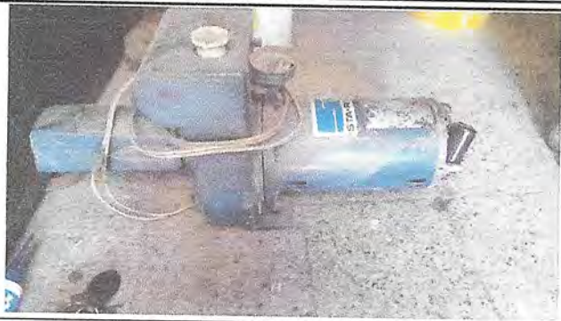
Reparación de red de drenajes y red de Agua potable.
