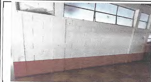
Pintura en muros interior y exterior (pintura en muros interiores en salones 442.80 m.2 e interiores pasillos, exterior general 1357.20 m.2)
