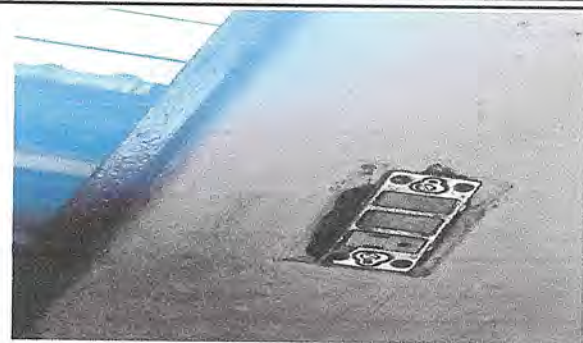
Reparación de sistema electrico en area de salones de primero y segundo nivel y en area de pasillos.
