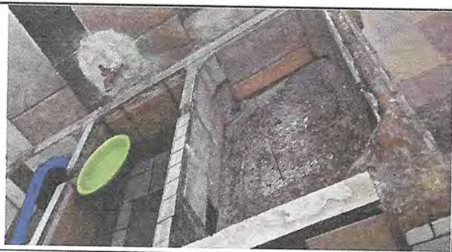
Reparación de red de drenajes y red de Agua potable.
