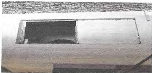
Ventanas (sustitución de vidrios y mantenimiento de estructura de metal, sustitución de piezas de metal en mal estado, 43.00m.2)
