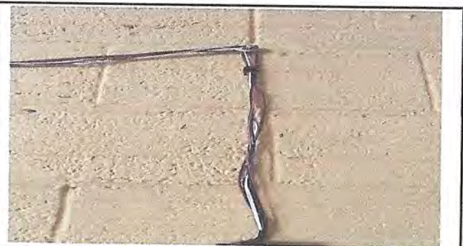
Reparación de sistema electrico en area de salones de primero y segundo nivel y en area de pasillos.
