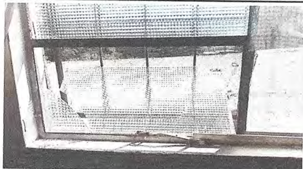
Ventanas (sustitución de vidrios y mantenimiento de estructura de metal, sustitución de piezas de metal en mal estado, 43.00m.2)
