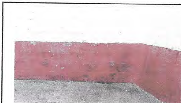
Pintura en muros interior y exterior (pintura en muros interiores en salones 442.80 m.2 e interiores pasillos, exterior general 1357.20 m.2)
