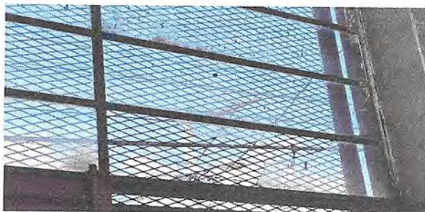
Ventanas (sustitución de vidrios y mantenimiento de estructura de metal, sustitución de piezas de metal en mal estado, 43.00m.2)
