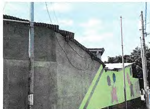
Foto 2: Suministro e instalación s de alambre de seguridad tipo razor sobre muro perimetral existente.
