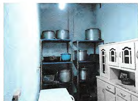
Foto 4: Implementación de mueble de cocina de 3 entrepaños de 70 cm de alta cada uno y 55 cm de profundidad con una losa de 7cm cada entrepaño.
