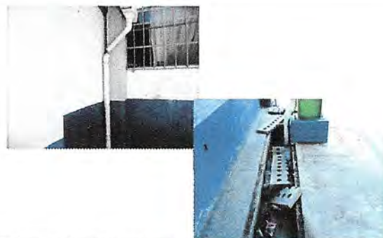
Foto 6: Sustitución de tubo de bajada de agua pluvial, canal pluvial averiado frente al salon de computación primaria y fabricacion de 7.00 tapaderas de concreto para cuneta pluvial en cancha.
