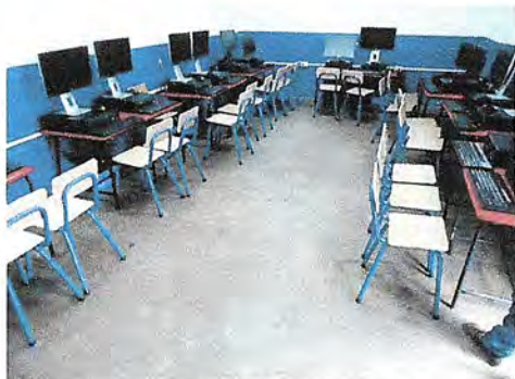
Foto1: Suministro e instalación de piso cerámico en aulas.
