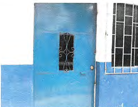
Foto 3: Fabricacion e instalación de puerta metálica tipo reja maciza 1.00 X 2.10 mts para salon de computación
