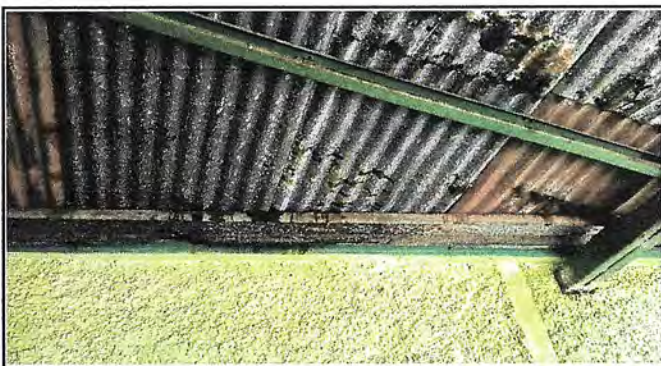
Foto 6: Las costaneras presentan un proceso de oxidación avanzado.
