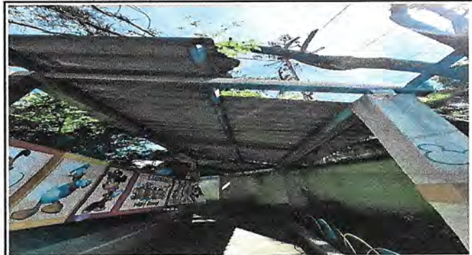
Foto 6: Se observa un deterioro significativo en la cubierta del pasillo, la oxidación ha causado la rotura de las láminas, permitiendo la entrada de agua en la entrada principal.
