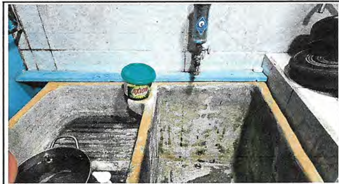
Foto 6: La pila de la cocina presenta un deterioro significativo debido a su antigüedad y uso continuo.
