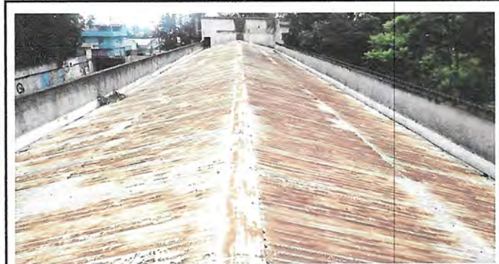
Foto 3: Sustrucción de lamina acanalada por lamina aluzinc calibre 26 de 640 mts cuadrados áreas laterales de escuela.
