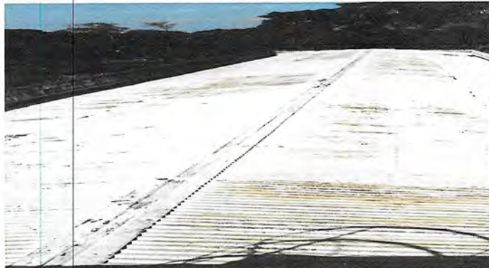
Foto 2: Sustrucción decapota de metal por capota de aluzinc calibre 26 de 80 mts lineal en áreas laterales de escuela.
