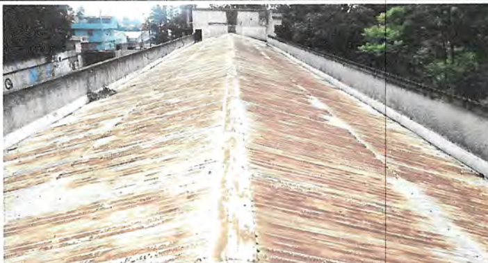
Foto 1: Sustrucción de lamina acanalada por lamina aluzinc calibre 26 de 640 mts cuadrados áreas laterales de escuela.
