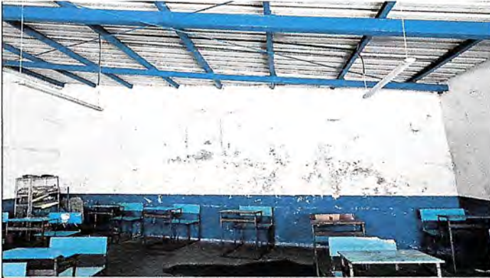
Foto 3: Reparación de techo con piezas lámina lisa tipo flashing con medidas de 0.20mX8pies en dos aulas y dirección que conforman 22.40 metros lineales.
