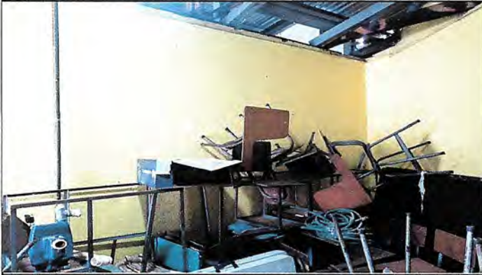
Foto 1: REPARACIÓN O SUSTITUCIÓN DE AREA DE COCINA: (Mesa de concreto con dimensiones 3.00m largo X 0.60m de profundidad X 0.90m alto, con cuatro divisiones mas gabinete aereo fundido en la misma ubicación con dimensiones 3.00m de largo X 0.50m de profundidad X 0.80m de alto con cuatro divisiones.
