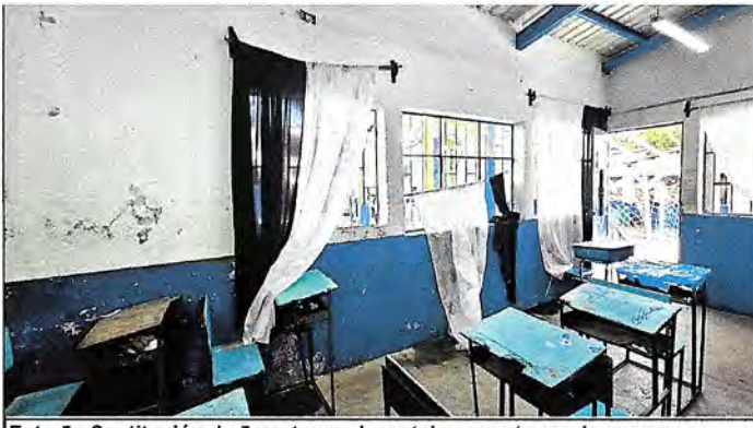
Foto 5: Sustitución de 5 ventanas de metal por ventanas de pvc con dimensiones 0.97mX1.16m, 1.087mX1.85m, 1.00mX1.72m, 1.00mX0.60m.
