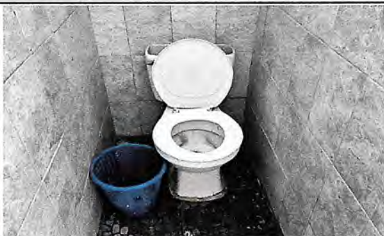
Foto 8: Sustitución de 3 sanitarios en mal estado en area de baños de niños.
