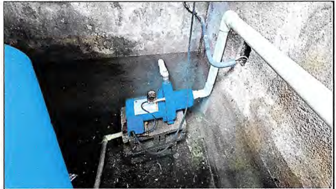
Foto 4: Sustitución de bomba de agua y mantenimiento de la instalación de tuberías en área de bomba y mantenimiento total de depósito de agua.
