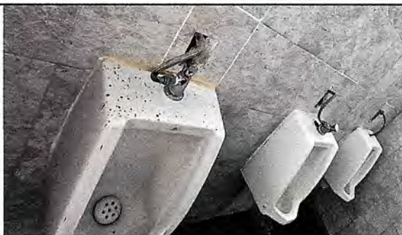
Foto 11: Sustitución de accesorios hidraulicos de 3 mingitorios en area de niños por llave de push.
