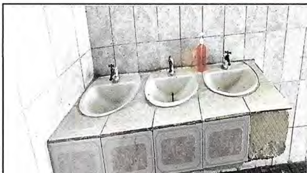
Foto 9: Sustitución de accesorios en lavamanos integrados por llave y sifon en 3 sanitarios en area de niños + sustitucion de azulejo.
