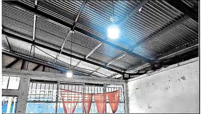
Foto 2: Sustitución de láminas dañadas en aulas
