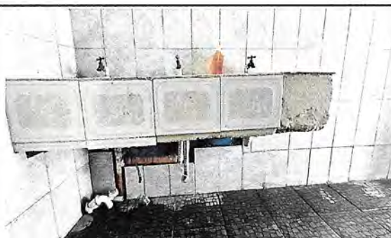
Foto 10: Sustitución de accesorios en lavamanos integrados por llave y sifon en 3 sanitarios en area de niñas + sustitucion de azulejo.
