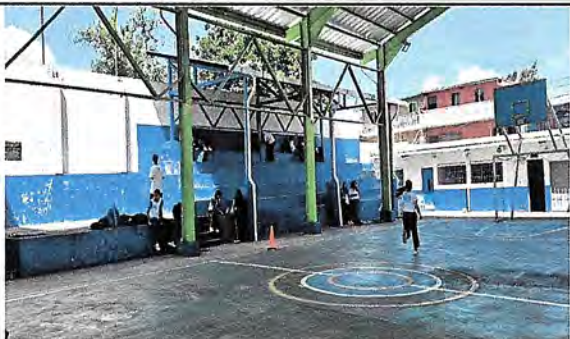
Foto 7: Pintura en exterior de establecimientos fachadas y graderios.
