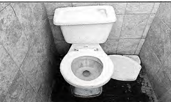
Foto 12: Sustitución de 3 sanitarios en mal estado en area de baños de niñas.
