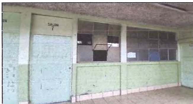
Foto: 5 Cambio de ventana exterior de salones
