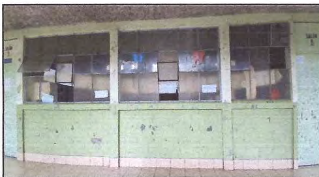
Foto: 3 Cambio de ventanas de salones interior del centro educativo
