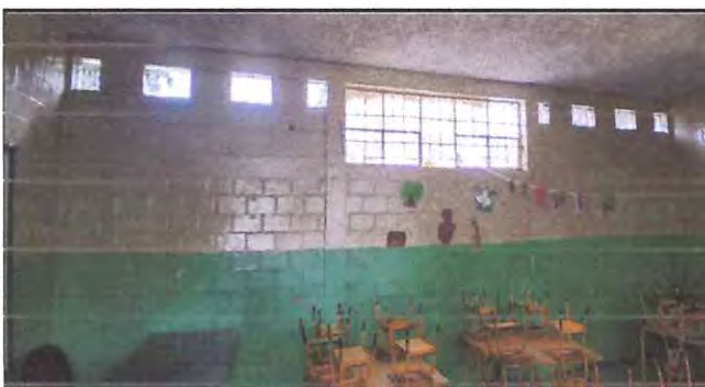
Foto: 6 cambio de ventana interior de salones
