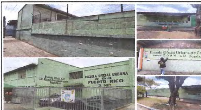
Foto: 1 Paredes exterior del establecimiento
