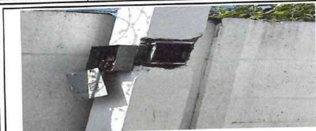
Foto: 1 Entrada principal de energía eléctrica
