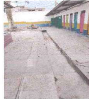
Foto: 4 Reparaciones en piso de concreto
