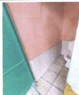
Foto: 4 Instalación de azulejo en la pared y cambio de piso
