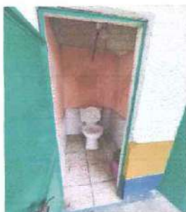
Foto: 3: Instalación de azulejo y cambio de piso
