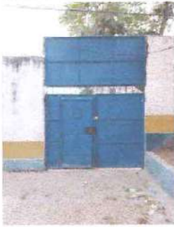
Foto 1: reparación de porton 6a. Avenida
