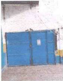
Foto 3: reparación de porton, eliminación de 1 fila de block y añadir metal
