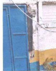
Foto 4: reparación de columna de concreto
