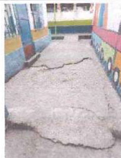
Foto: 2 levantado de una hilera de block
