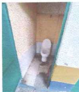
Foto: 5 Instalación de azulejo en la pared y cambio de piso
