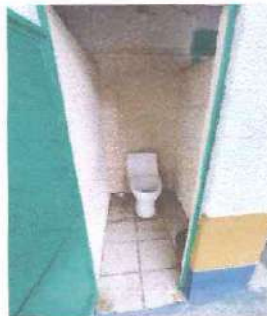
Foto: 2 Instalación de azulejo en la pared y cambio de piso
