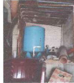
Foto: 2 Mejora en sistema de bombeo
