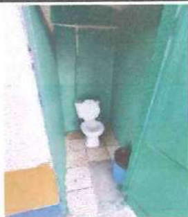
Foto: 1 Instalación de azulejo en la pared y cambio de piso
