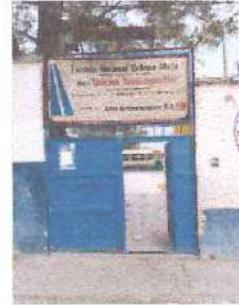
Foto 2: Agregado de metal al portón principal para hacerlo más alto
