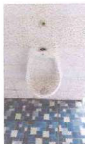
Foto: 6 Reparación de llaves de push
