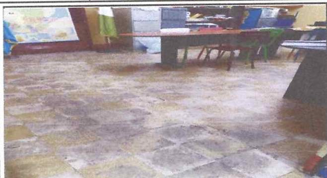
Foto: 1 Cambio de piso de aula
