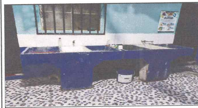
Foto: 5 Cambio de pilas y limpieza de tubería
