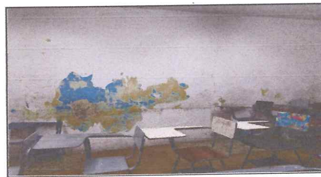
Foto: 6 Reparación de paredes en aulas
