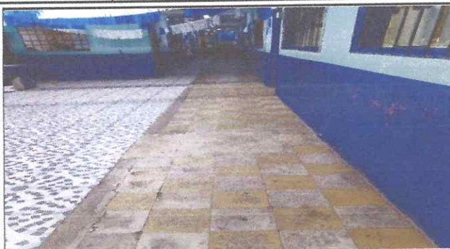
Foto 2 Cambio de Piso de corredor
