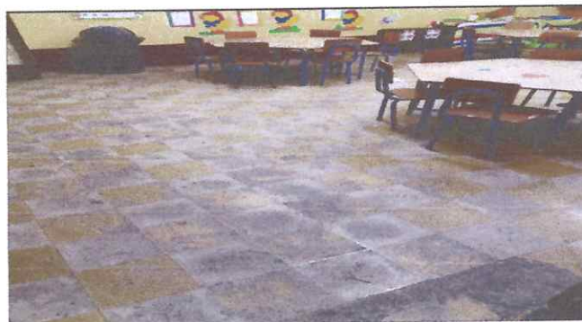
Foto: 4 Cambio de piso en aula
