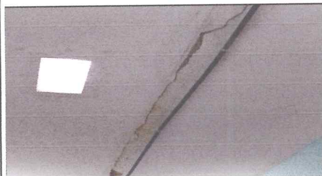
Foto: 3 Reparación de techo de pasillo
