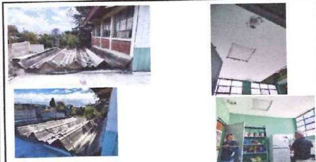
Foto: 3 Estructura de techo cambio de lamina duralita Aula y Cielo falso de Conina 1mer. Nivel
