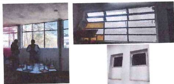
Foto: 5 Sustituir Ventanas de PVC
