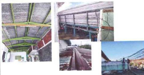
Foto: 2 Estructura de Techo Ingreso Principal
