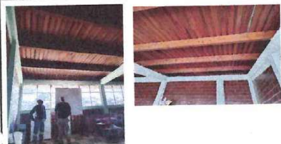
Foto: 1 Estructura de techo Aula 2do. Nivel
