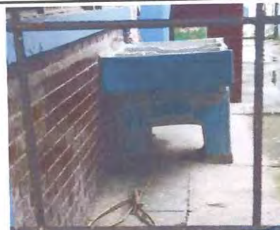
Foto: 6 Cambio de pila
