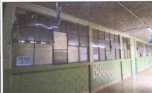
Foto: 3 Cambio de ventanas primer nivel
