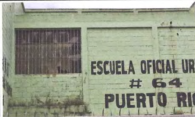
Foto: 1 Cambio de ventana frontal
