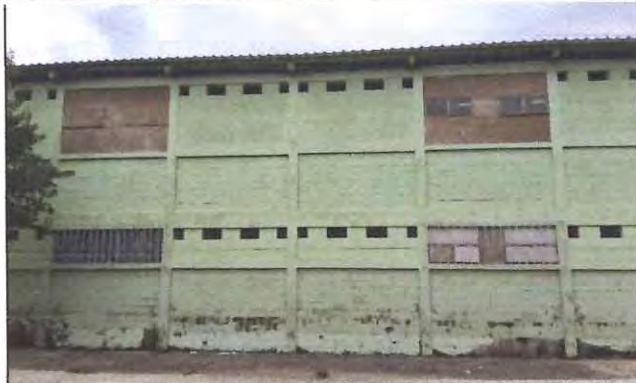
Foto: 2 Cambio de ventana frontal
