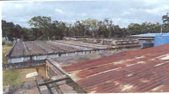
Foto 2: Loza Módulo de Taller Mantenimiento y Reparación de Computadoras y Taller de Electricidad
