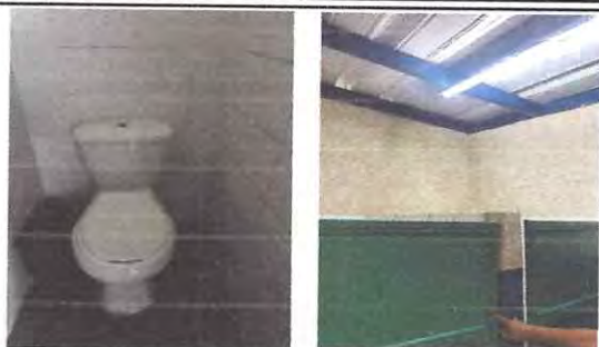
Foto: 1 CAMBIO DE SANITARIOS Y MANTENIMIENTO DE PUERTA
