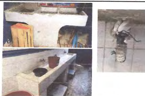
Foto: 2 CAMBIO DE PILA, CAMBIO DE CHORROS Y SIFONES E INSTALACION DE AZULEJO
