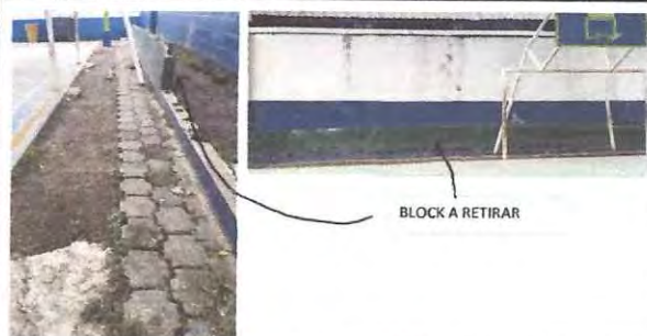
Foto: 11 RETIRO DE HILADAS DE BLOCK, FUNDICION DE TORTA Y PINTURA
