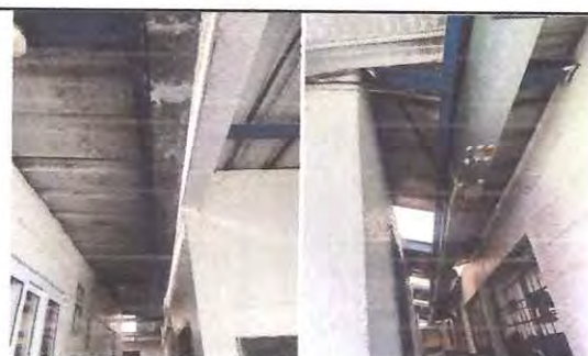
Foto: 9 CAMBIO DE CANALES
