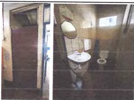
Foto: 3 MANTENIMIENTO DE PUERTA, CAMBIO DE AZULEJO, SANITARIO Y LAVAMANOS
