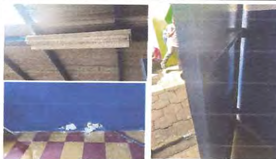
Foto: 4 CAMBIO DE PLAFONERAS, LAMPARAS, MANTENIMIENTO DE PUERTAS Y REPARACION DE PARED DE TABLA ROCA
