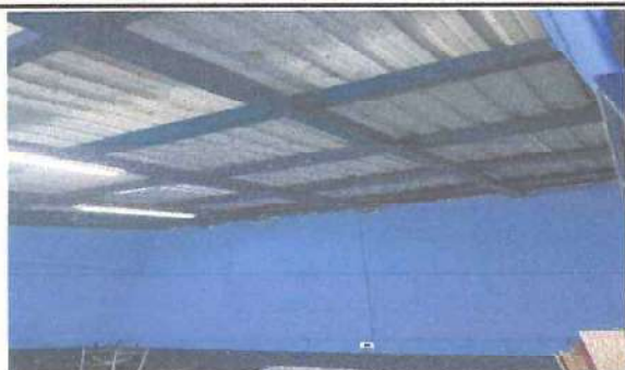
Foto: 9 Techo de dirección
