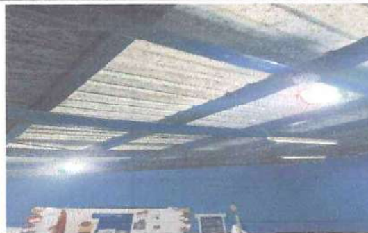
Foto: 8 Techo de dirección
