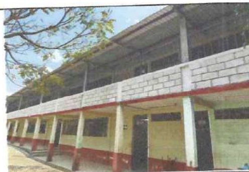
Foto: 6 Barandal de Segundo Nivel
