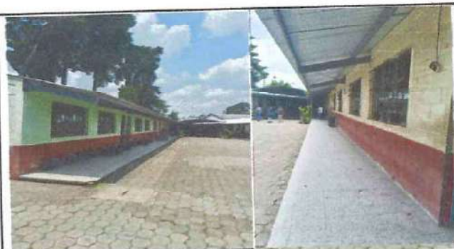
Foto: 5 Área de pintura de aulas
