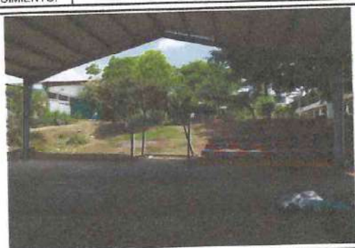
Foto: 1 Área de cancha Polideportiva
