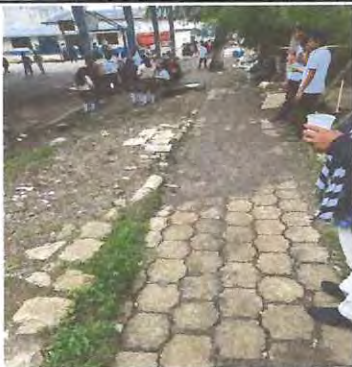
Foto: 3 Remozamiento de rampa con cunetas para redirigir la corriente hacia drenaje de cancha. Vista de arriba hacia abajo
