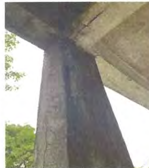
Foto: 4 Remozamiento de columna
