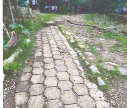
Foto: 2 Remozamiento de rampa. Vista de abajo hacia arriba
