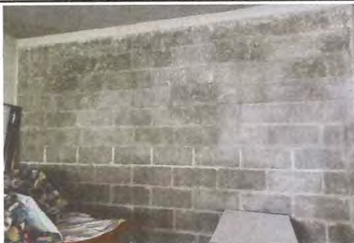
Foto: 5 Aplicación de impermeabilizante
