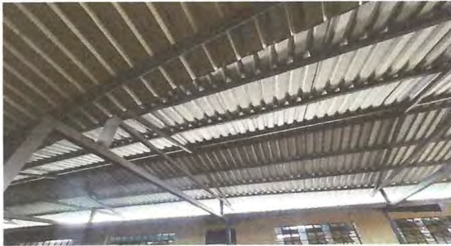
Foto: 1 Instalacion de canales
