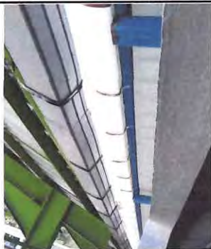
Foto: 1 Limpieza de canales
