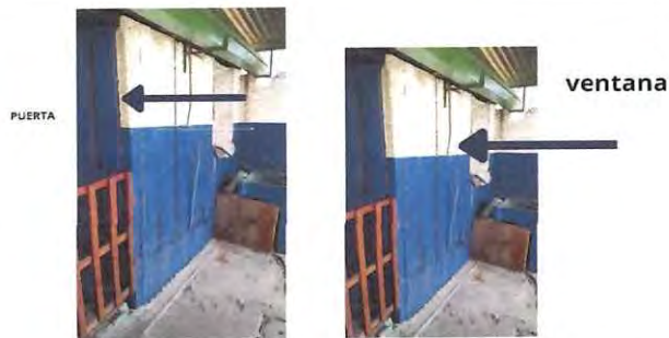
Foto: 5 Instalacion de puerta y ventana
