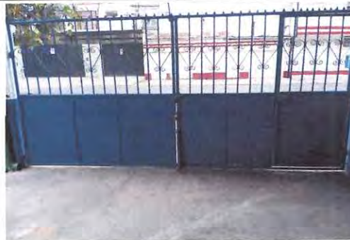
Foto: 4 Mejoramiento de porton principal
