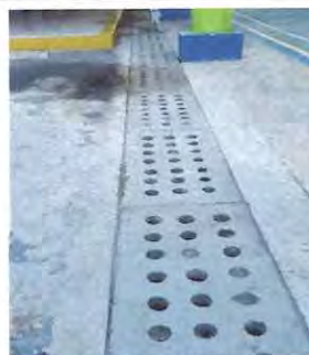
Foto: 6 Limpieza de cunetas en la cancha
