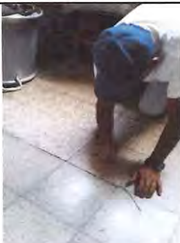
Foto: 1 Reparación y nivelación de piso en cocina
