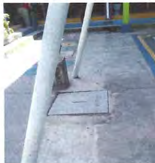
Foto: 2 Limpieza de 3 cajas de registro
