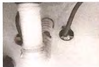
Foto: 4 Cocina: Cambio de sifones de lavatrastes y resane de pared en taller industrial de panadería
