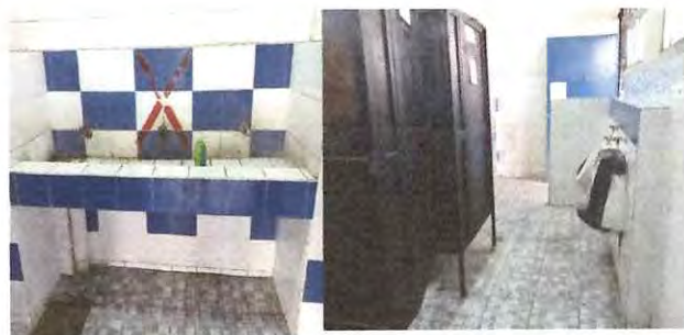
Foto: 6 Reparación de drenajes, cambio de accesorios de migitorios, sanitarios de los estudiantes y mantenimiento de migitorios, azulejo reparación y pintura de puertas que dividen los sanitarios. Cambio de chorros, corrección de
