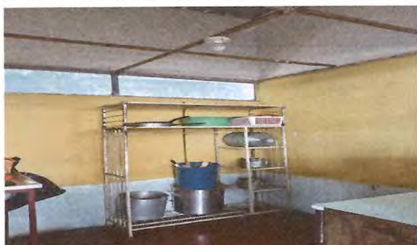
Foto: 3 Bodega para alimentos: cambio de piso, colocación de cielo falso, pintura, reconexión de energía eléctrica, estanterías de metal y cambio de ventanas.
