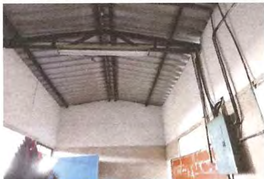
Foto: 1 Cocina: Corrección de energía eléctrica, cambio de canal y 5 ventanas
