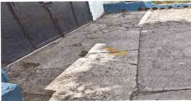
Foto: 3 Reparacion de torta de cemento en entrada principal
