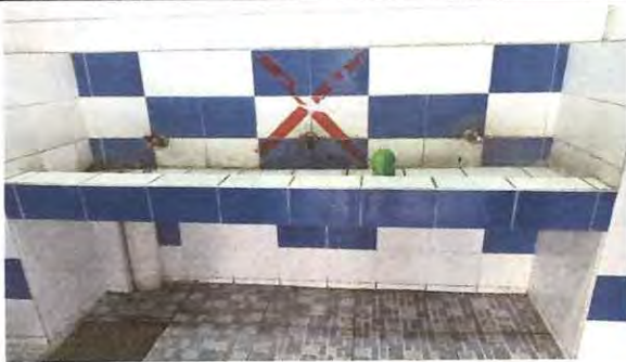
Foto: 1 Cambio de chorros y corrección de drenajes para cada chorro.
