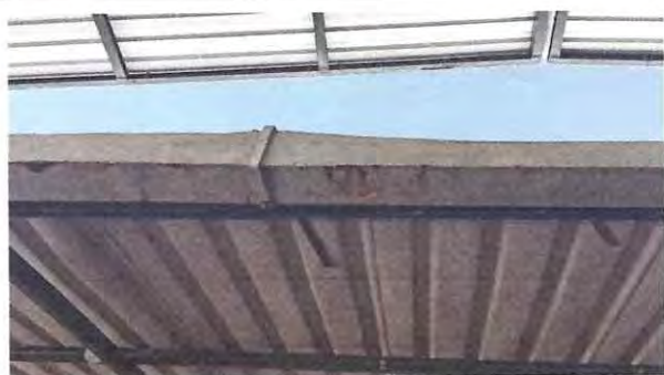
Foto: 5 Cambio de canal y mantenimiento de bajadas de agua.
