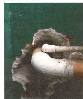
Foto: 4 Cocina: Cambio de sifones de lavatrastes y resane de pared en taller industrial de panadería
