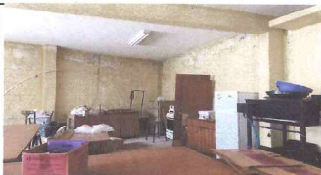
Foto: 3 Muro y cielo de biblioteca
