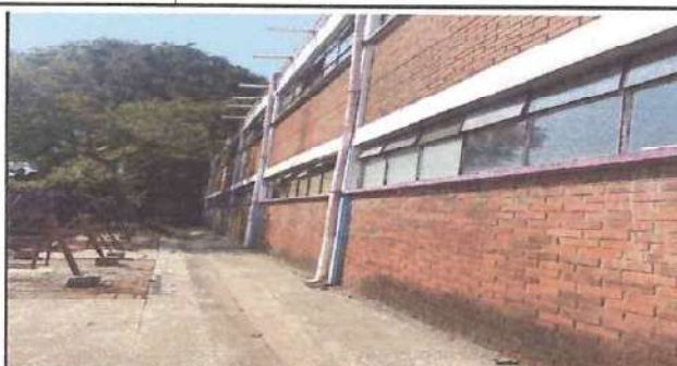
Foto: 2 Remozamiento de bajadas de agua
