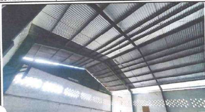
Foto 3: CUBIERTA DE LAMINA (Techo salón de usos multiples)
