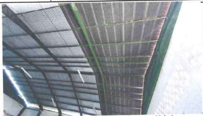
Foto 3: CUBIERTA DE LAMINA (Techo salón de usos multiples)
