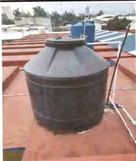
Foto: 1 Cambio de deposito de agua
