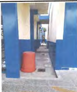
Foto: 5 Bodegas nuevas y colocacion de piso
