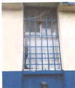
Foto: 3 Cambio de ventanas cocina
