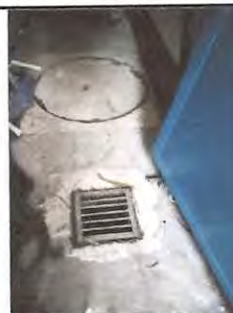
Foto: 6 Piso para bodega
