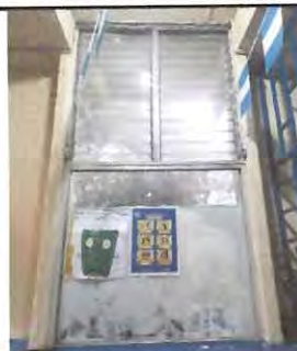
Foto: 4 Cambio de ventanas salones
