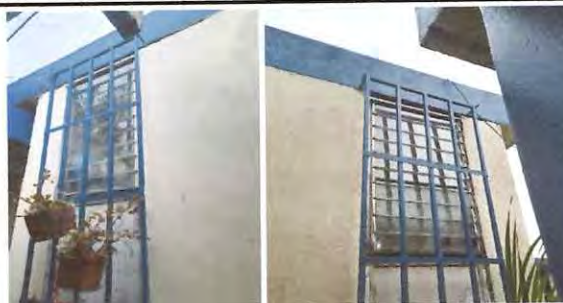
Foto: 2 Cambio de ventanas direccion
