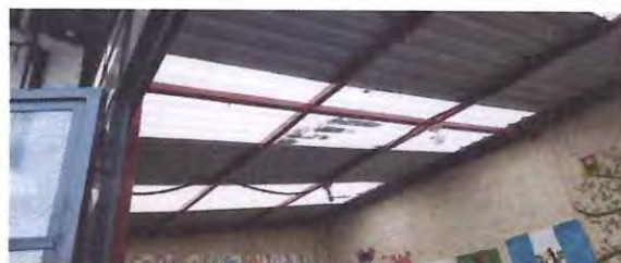
Foto: 2 Cambio de lamina e instalacion de cielo falso en salon de lectura
