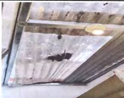
Foto: 1 Cambio de lamina y cableado para plafonera y bombilla en bodega
