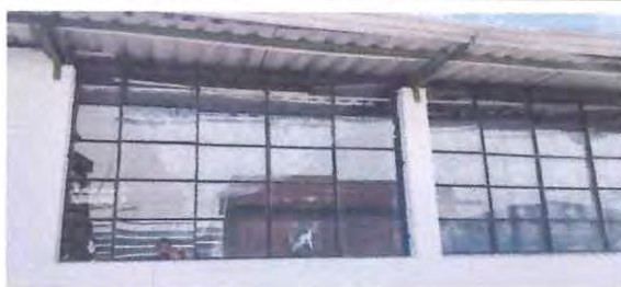
Foto: 5 Cambio de ventanas a pvc
