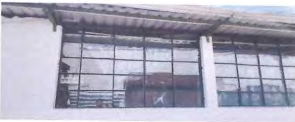
Foto: 9 Impermeabilización de techo
