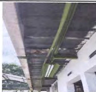
Foto: 6 Cambio de lamina en salones
