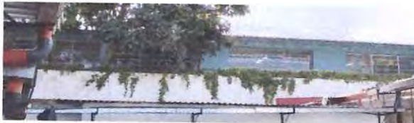
Foto: 7 Impermeabilización de pared trasera area superior
