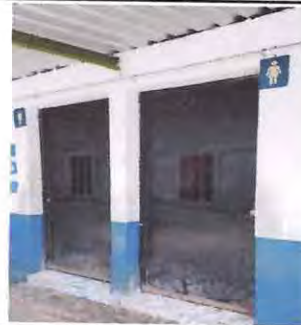
Foto: 8 Mantenimiento de puertas
