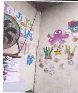
Foto: 10 Remozamiento de pared y reposición de columnas
