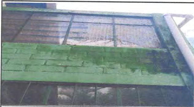
Foto: 5 Las paredes ya están sufriendo mucho daño, en la parte exterior como interior por la filtración de agua
