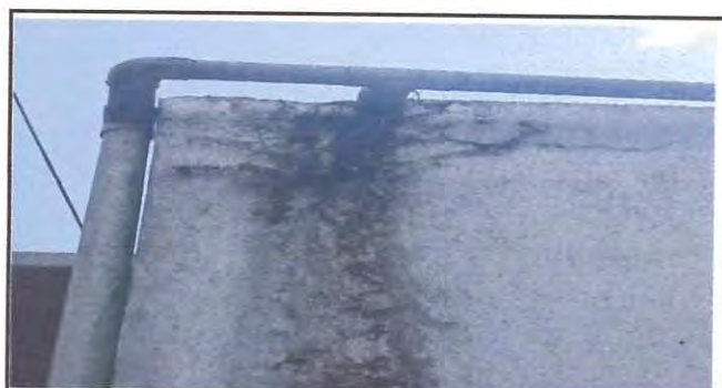
Foto: 6 La pared del otro costado, es necesario realizar otra bajada de agua pluvial.
