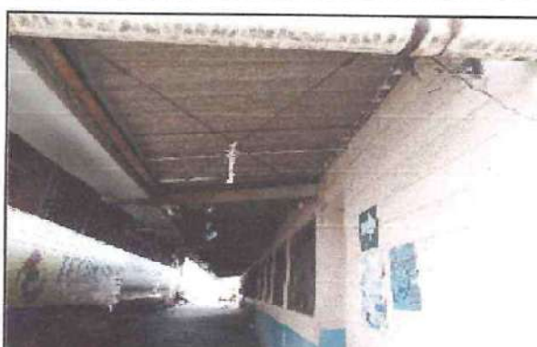
AREA ADMINISTRATIVA VISTA DE SUR A NORTE
