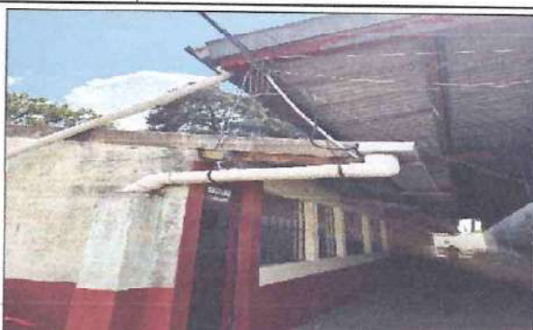
AREA DE VISTA DE NORTE A SUR DEL AREA ADMINISTRATIVA
