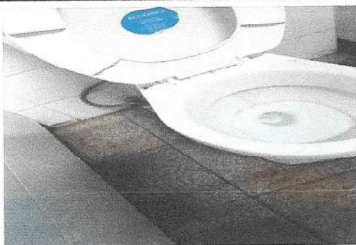
Foto No. 1 Reparación de red de drenajes y red de agua potable. Cambio total de tubería de drenaje de sanitarios del 2o. nivel, realizando instalación nueva con tubería PVC de 4 pulgadas con todos sus
