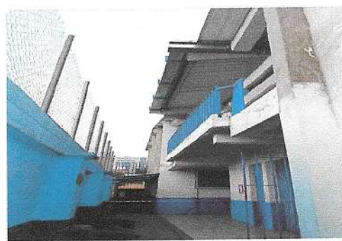
Foto No. 4 Extensión de techo metálico para corredor de 1.70 ancho por 12 largo con canal calibre 26 fabricado con lamina lisa calibre 26 y estructura de tubo cuadrado de 2*2 chapa 18 y lamina troquelada calibre 26 con 3
