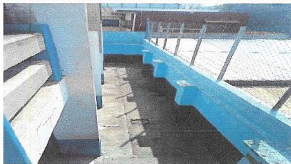
Foto No. 7 Instalación de pila de concreto de dos lavaderos con tubería de drenaje y agua potable con sus accesorios. En 1o. nivel
