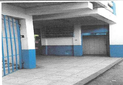
Foto No. 2 Adecuación de área para sanitario en primer nivel de 1.26 metros cuadrados, sanitarios con instalación de drenajes y agua potable.
