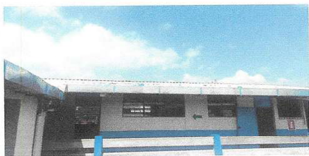
Foto No. 5 Instalación de capote metálico para el techo de las aulas del segundo nivel, elaborado con lamina aluzinc calibre 26 de 1.20 de ancho por 15 metros de largo.
