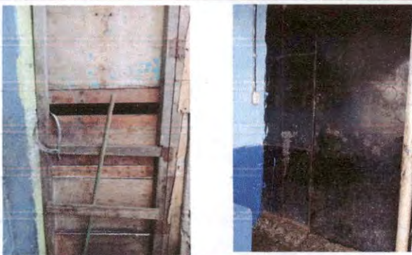
FOTO 3 SUSTITUCIÓN DE DOS PUERTAS DE BODEGA.
