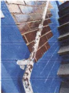
FOTO 7 SUSTITUCIÓN DE PASAMANOS COMPLETO POR DE ACERO INOXIDABLE
