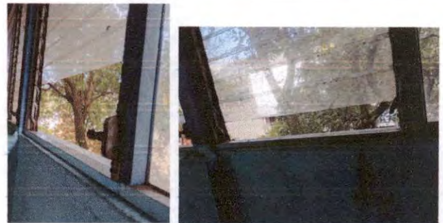
FOTO 2 SUSTITUCIÓN DE VENTANAS DEL SALÓN
