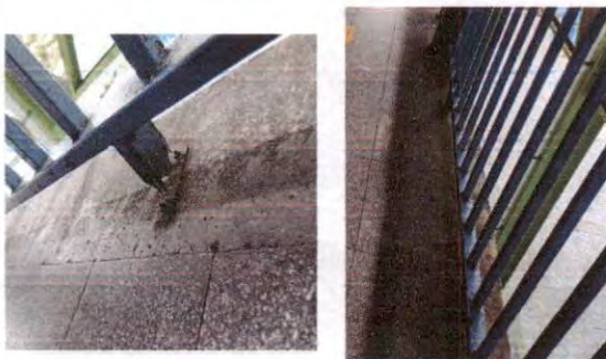
FOTO 5. SUSTITUCIÓN DE BARANDAS
