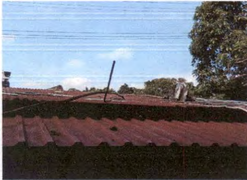
FOTO1 : CAMBIO DEL TECHO DE LA BODEGA.
