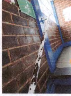
FOTO 7 SUSTITUCIÓN DE PASAMANOS COMPLETO POR DE ACERO INOXIDABLE
