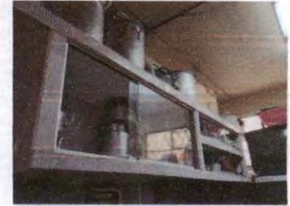
FOTO 8 SUSTITUCIÓN PUERTAS DE GABINETE COMPLETAS POR DE PVC
