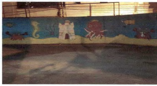
Foto 2: Mantenimiento de pintura en muro perimetral del patio 2
