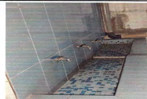
Foto: 12 Reparación y ampliación de lavamanos y cambio de chorros dañados
