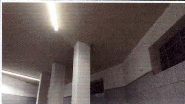
Foto: 11 Reparación de ventanería
