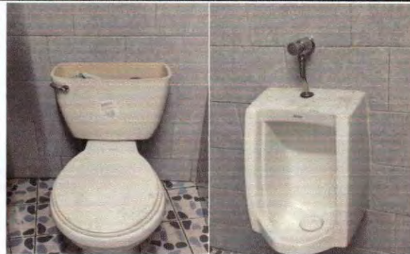
Foto: 8 Cambio de 4 sanitarios dañados y 3 mingitorios dañados
