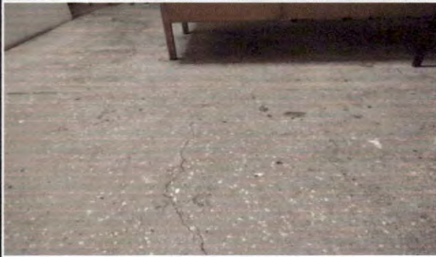
Foto:1 Reparación de piso en dirección
