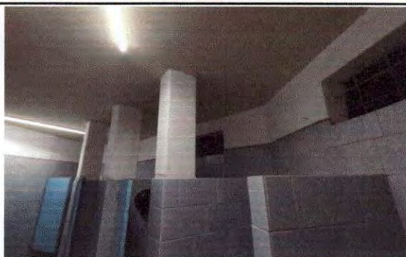
Foto: 9 Mantenimiento de puertas metálicas en baños
