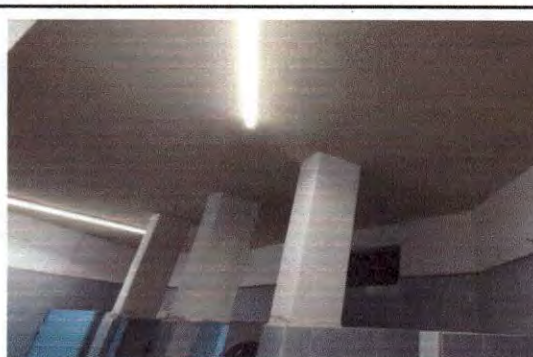
Foto: 10 Reparación y ampliación de muros divisorios y cambio de azulejo dañado
