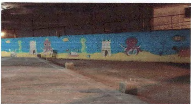
Foto 3: Mantenimiento de pintura en muro perimetral del patio 2
