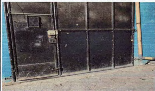
Foto: 7 Reparación de portón dañado por la corrosión en la parte inferior y pintura general
