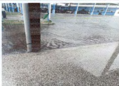
Cuneta de concreto sobre entrada
