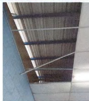
Reparación de goteras y cielo suspendido reticulado sobre aulas y pasillos de la escuela.
