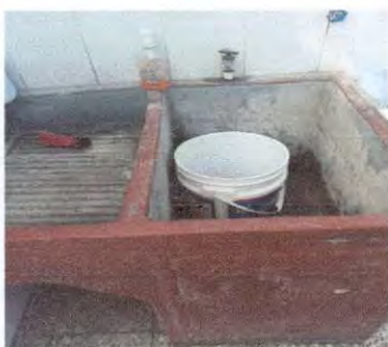
Sustitución de pila en área de sanitarios.
