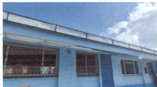
Limpieza de canales y bajadas de agua pluvial
