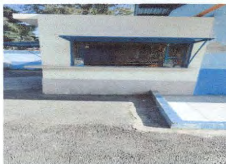
Reparación de losa de patio
