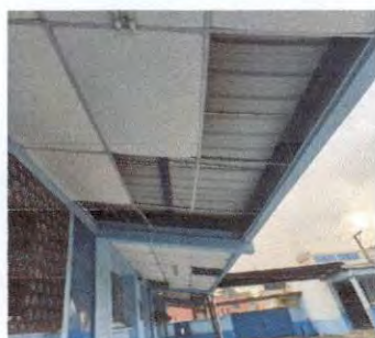
Reparación de goteras y cielo suspendido reticulado sobre aulas y pasillos de la escuela.
