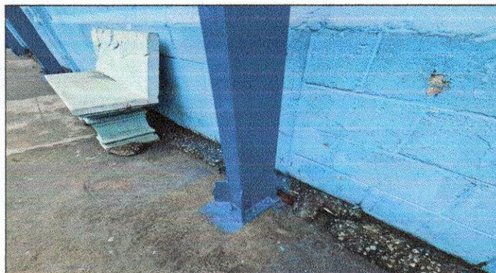
Foto 4: Base para techo
