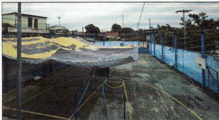
Foto 1: Patio frontal con 14 bases para techo.
