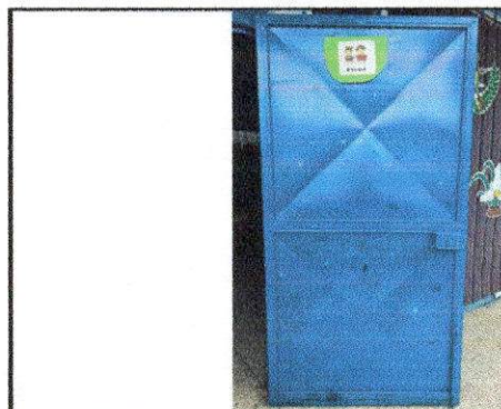
Foto 6: Puerta del salón de preparatoria
