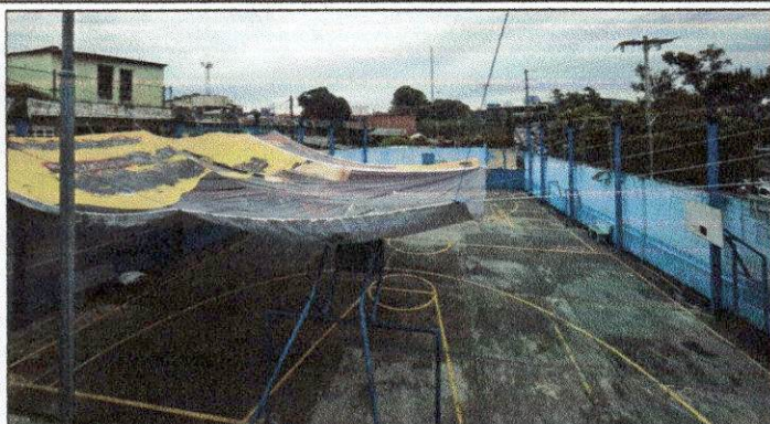
Foto 1: Patio frontal con 14 bases para techo.
