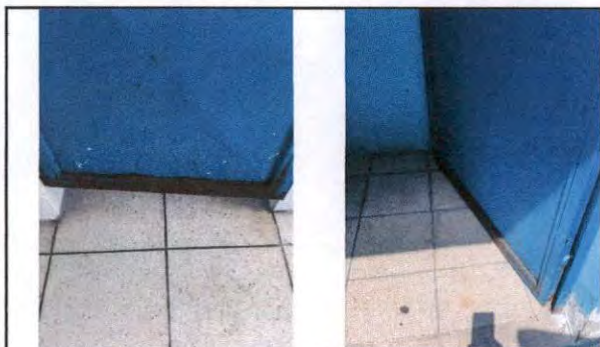
Foto 5: REPARACIÓN DE PUERTAS EN BAÑOS Y EN COCINA
