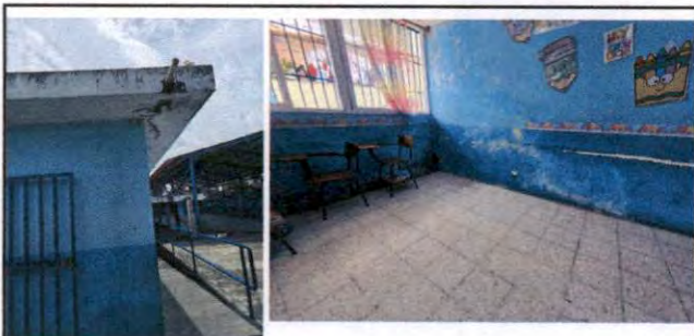
Foto 5: BAJADAS DE AGUA PLUVIAL, IMPERMEABILIZACION EN MURO (ACTULAMENTE HAY HUMEDAD EN LOS MUROS )
