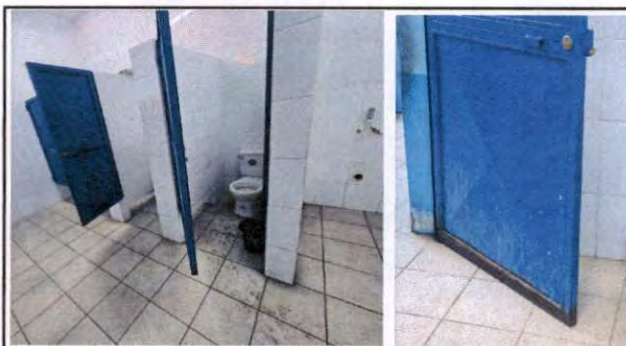
Foto 4: REPARACION DE PUERTAS EN LA PARTE INFERIOR
