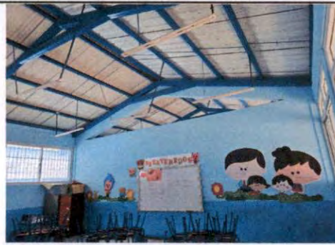
Foto 2: LEVANTADO DE MURO PARA INDEPENDIZAR LAS AULAS, ACTUALMENE HAY INTERFERENCIA ENTRE AULAS
