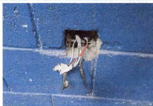
FOTO 4: ÁREA DONDE SE REALIZARÁ LA INSTALACIÓN DE TOMACORRIENTES.
