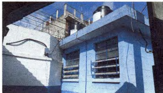
FOTO 2: ÁREA DONDE SE REALIZARÁ INSTALACIÓN DE CABLEADO.
