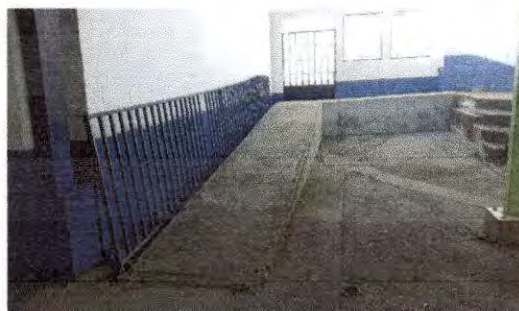
FOTO 6: ÁREA DONDE SE REALIZARÁ INSTALACIÓN DE RAMPA.
