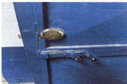
FOTO 3: ÁREA DONDE SE REALIZARA LA SUSTITUCIÓN DE CHAPAS YALE.
