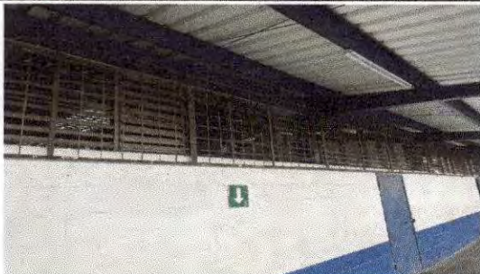
FOTO 1: ÁREA DONDE SE REALIZARÁ LA SUSTITUCIÓN POR VENTANAS PVC.
