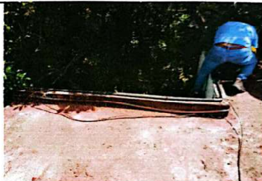
Levantado de techo para impermeabilización
