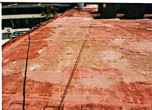
Levantado de techo para impermeabilización
