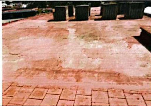
Levantado de techo para impermeabilización
