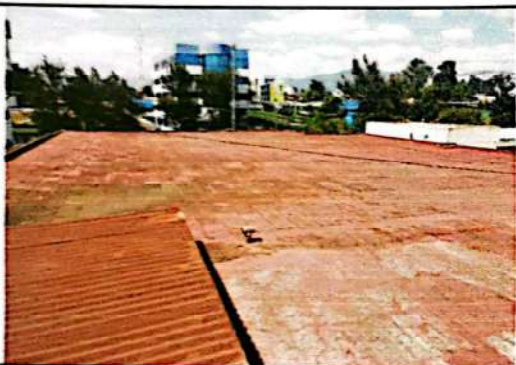
Levantado de techo para impermeabilización
