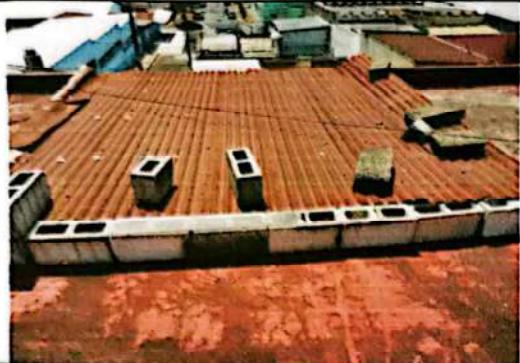
Levantado de techo para impermeabilización
