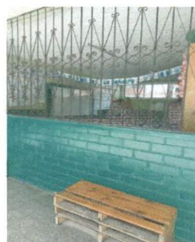
CAMBIO DE VENTANAS DE LOS GRADOS PREPA, PRIMERO Y SEGUNDO
