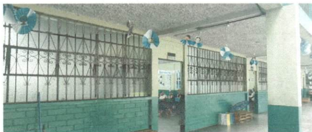
CAMBIO DE VENTANAS DE LOS GRADOS PREPA, PRIMERO Y SEGUNDO
