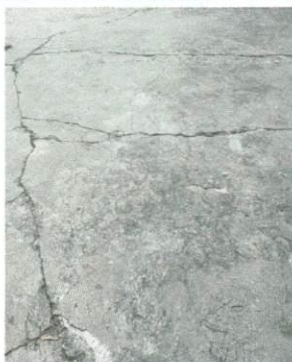
levantamiento DE LOZA DE PATIO
