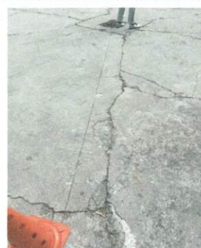
levantamiento DE LOZA DE PATIO
