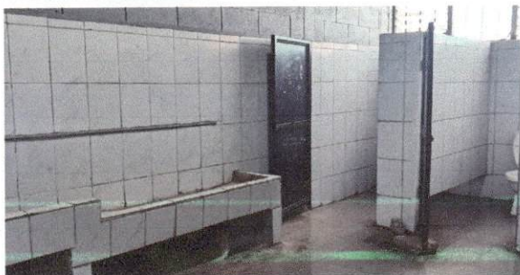
Foto1: REPARACION O SUSTITUCION DE AZULEJOS
