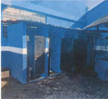
Foto1: Instalación de piso y azulejo en baños, cernido exterior y mantenimiento de puertas
