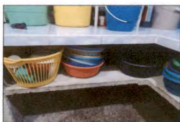
Foto 3: instalacion de azulejo en isla de concreto
