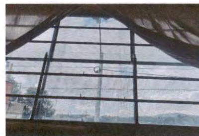
Foto 6: Sustitucion de estructura de metal ventanas segundo nivel
