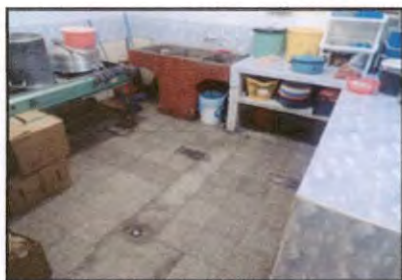
Foto 1: Instalación de piso y azulejo cocina
