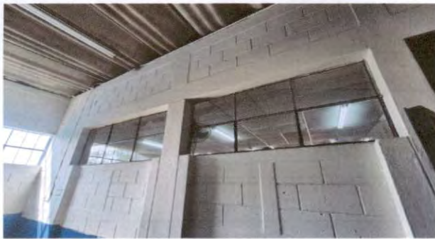
Foto 3: cambio de 6 ventanas por pvc ubicados en el nivel 2
