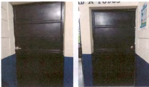
Foto 5: Cambio de puerta de metal de dirección y salón de maestros
