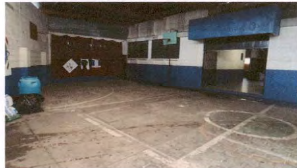
Foto 4: Pintura en muros
