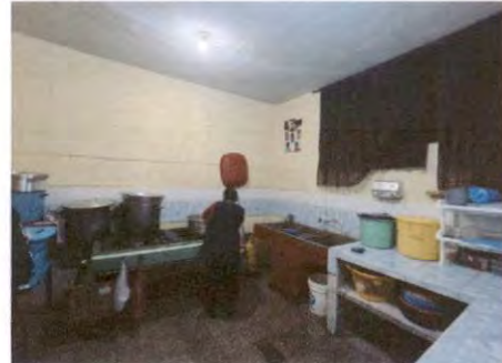
Foto 2: Cambio de piso y azulejo en cocina además de cambio de venta, pintura en pila, mantenimiento de puerta y reposadera
