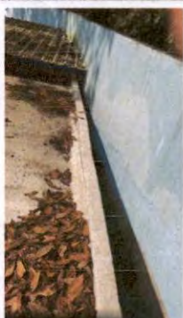
Foto 1: SE OBSERVA LA SEPARACION ENTRE EL MURO PERIMETRAL Y EL MURO DEL AULA, CAUSANDO FILTRACION, HUMEDAD Y DETERIORO DEL MURO
