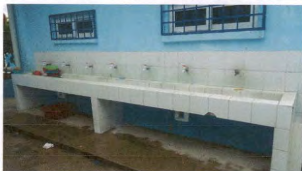
Foto 5: SITUACION ACTUAL DE LAVAMANOS CON CHORROS, ES NECESARIO SUSTITUIRLOS POR LLAVES QUE REGULEN EL CONSUMO DE AGUA.
