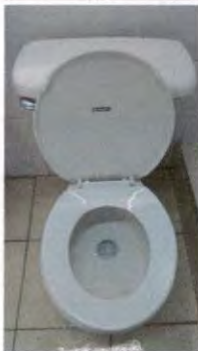
Foto 11: SANITARIOS EXISTENTES EN SERVICIO SANITARIO DE MAESTROS, SE SUSTITUIRAN POR FUGAS DE MAL FUNCIONAMIENTO EN TANQUE.
