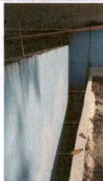
Foto 1: SE OBSERVA LA SEPARACION ENTRE EL MURO PERIMETRAL Y EL MURO DEL AULA, CAUSANDO FILTRACION, HUMEDAD Y DETERIORO DEL MURO
