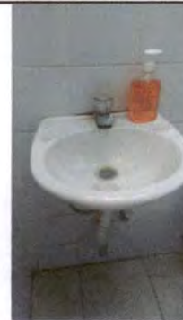
Foto 12: LAVAMANOS EXISTENTES EN SERVICIO SANITARIO DE MAESTROS, SE SUSTITUIRAN POR UNOS DE MEJOR FUNCIONAMIENTO CON PEDESTAL.
